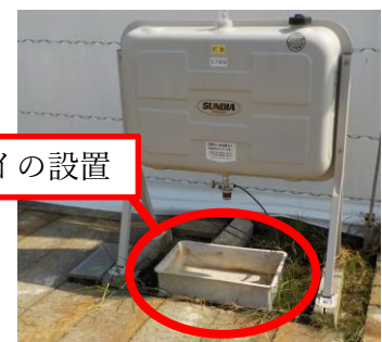
【燃料の漏出防止対策例】
